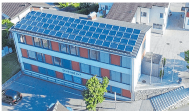
An der Schlinsener Gemeindestube nagt der Zahn der Zeit. Für rund 210.000 Euro soll das Gebäude daher auf Vordermann gebracht werden.
